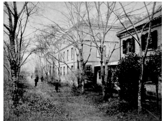
fig. 1 1 号館との渡り廊下が見える
