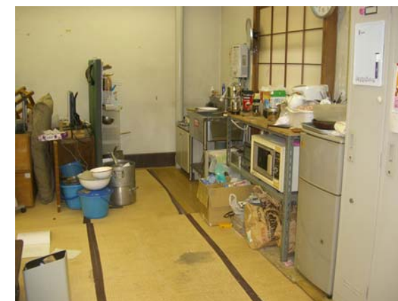
2階 北側（アトリエ 水栓回り）
