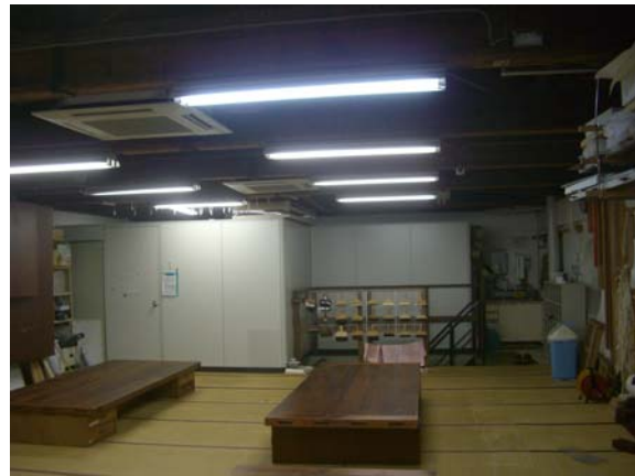
屋根裏 (南面 階段室)
