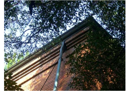
軒とい・立てとい 腐朽状況 立てとい： とい脱落部補修、つかみ金物破損部修繕
