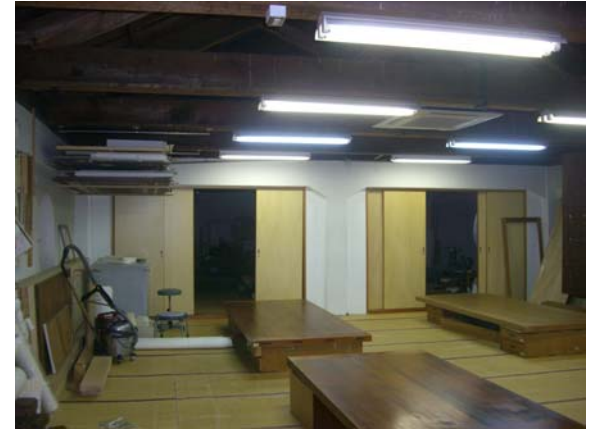
屋根裏 (中央仕切り壁 南面)
