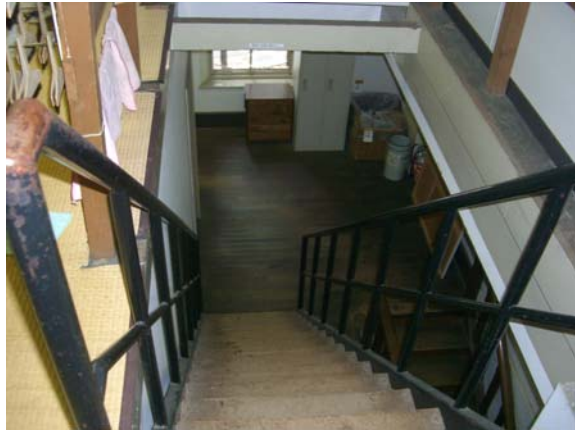
2 F ~ 3 F (屋根裏) 階段室
