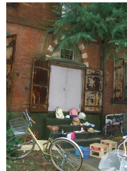
東側中央（建設時の玄関）
