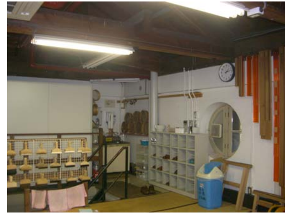
屋根裏南西隅面 (階段室 水栓回り)
